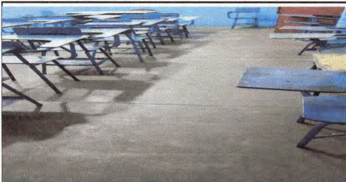
Foto 3: Piso del salón 3
