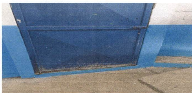
Foto 5: Mantenimiento a puerta de metal por deterioro por oxidación en la parte de abajo . Salones 3,6,7 y sanitario de niños.
