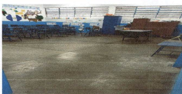
Foto 4: Cambio de piso de cemento a piso cerámico debido a que esta deteriorado .
