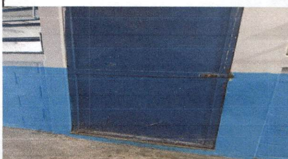
Foto 6: Mantenimiento a puerta de metal por deterioro por oxidación en la parte de abajo . Salones 3,6,7 y sanitario de niños.
