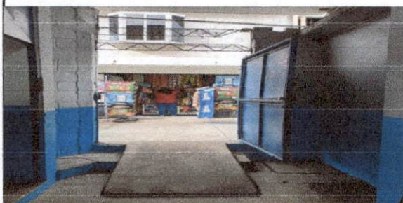
Foto 5: Mejoramiento de rampa de acceso al establecimiento
