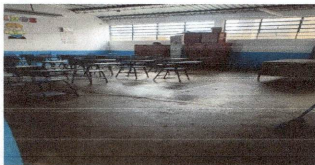
Foto 3: Cambio de piso de cemento a piso cerámico debido a que esta deteriorado .
