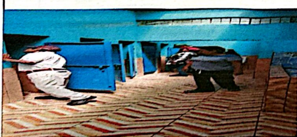
Foto 5: puertas deterioradas, dificultad para abrir, desgaste en las bisagras,
