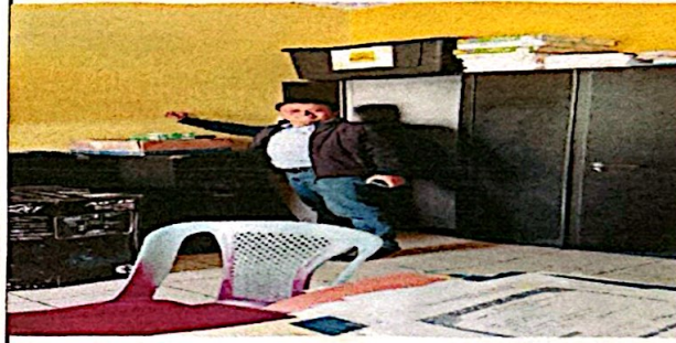
Foto 4: Vista del supervisor educativo verificando daños en la dirección debido al sismo
