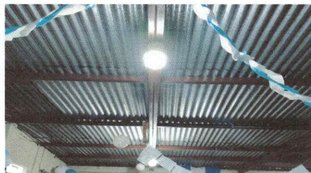
Foto 2: Mejoramiento de techo y de muro perimetral.
