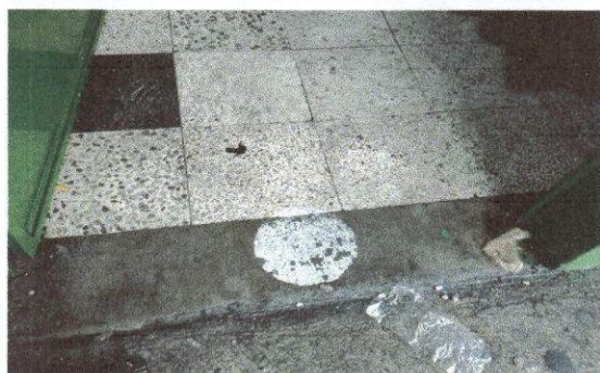
Foto 5: Sustitución de piso.
