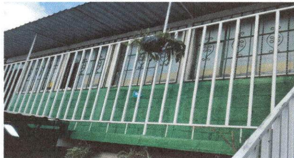
Foto 4: Mejoramiento de muro perimetral y techo.
