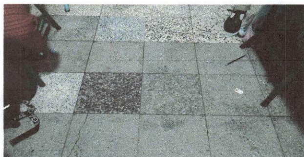
Foto 3: Sustitución de piso
