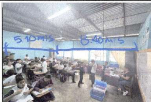
Foto 3: Suministro de lamina troquelada aluzinc calibre 26. en (modulo 2 aulas)
