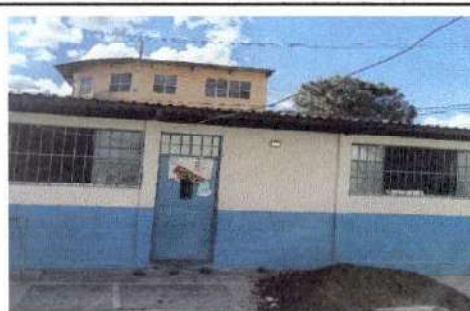
Foto 6: Sustitución de canal metalico en modulos de aulas 1, 3.
