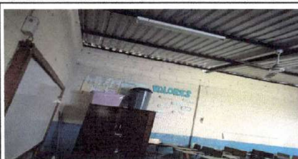
Foto 2: Sustitución de lamina, por lamina troquelada aluzinc calibre 26 (modulo 1 aulas)
