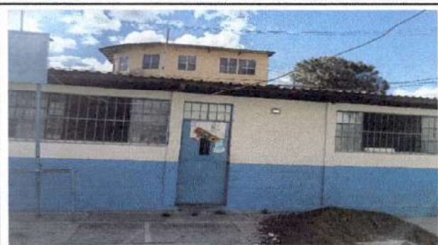
Foto1: Sustitución de lamina, por lamina troquelada aluzinc calibre 26 (modulo 1 aulas)
