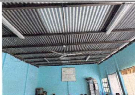
Foto 5: Mantenimiento a estructura de soporte de metal (modulo 2 aulas)
