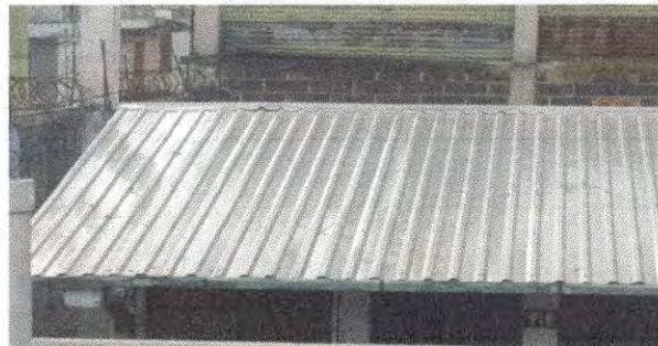
Foto 6: Techos con laminas cortadas, goteras y mal colocadas el agua se filtra entre las uniones
