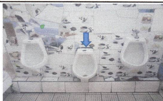
FOTO 4. Reposicion de llave push de migitorio modulo B
