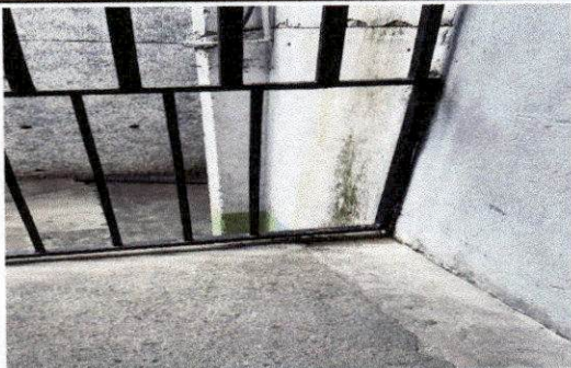
FOTO 19. Sustrución de 2 barotes de baranda del mudulo 1
