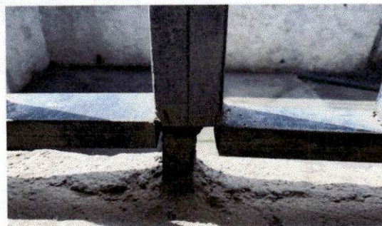
FOTO 20. asegurar y sustituir barrote de baranda del mudulo 1
