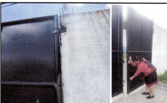
FOTO 10. Porton con visagras rotas y marco torcido doblado por un camion que imposibilita abrirlo en caso de emergencia.
