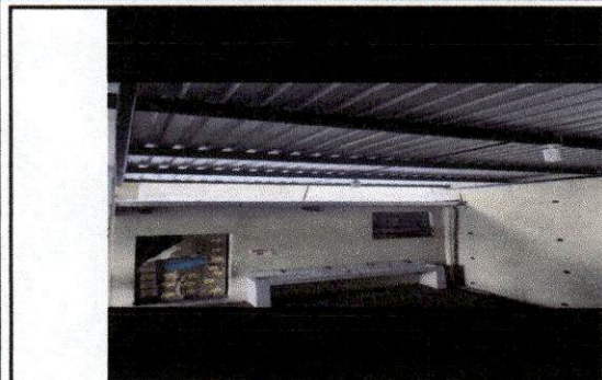
FOTO 7. Reemplazo de lámina de policarbonato para evitar ingreso de agua y que aclare el lugar
