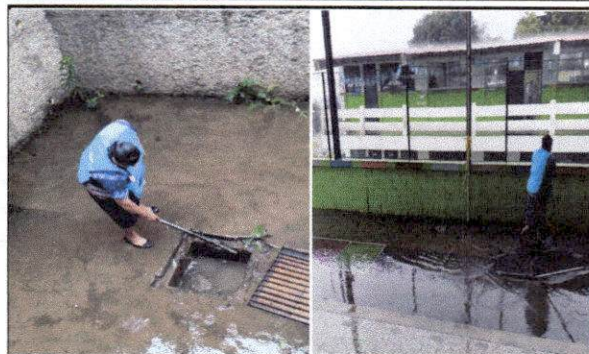
FOTO 14. Limpiar reposadera y canales del modulo a y b
