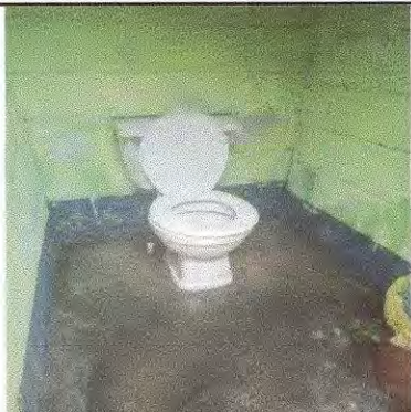
Foto 1: 5 Baños individuales Niños(as) pequeños. Cambio de inodoors (5), colocación de puso y azulejo
