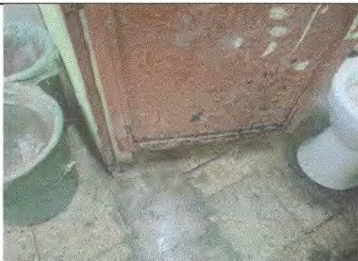
Foto 3: Bateria de baños para Hombres 4° a 6° Grado. Cambio de piso, inodoros y arreglo de puertas.
