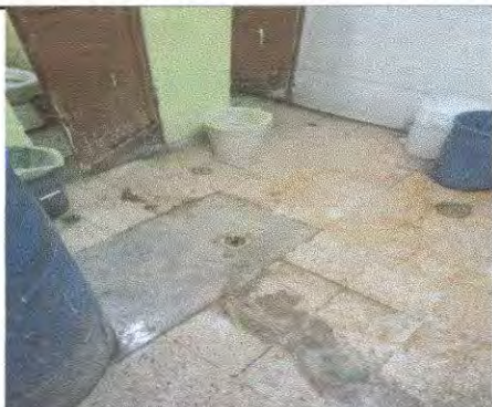
Foto 3: Bateria de baños para Mujeres de 4° a 6° grado, Cambiar piso, cambiar azuejo y arreglar las puertas.
