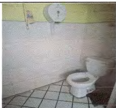
Foto 5: Baño 1 para docentes. Cambio de piso y de inodoro
