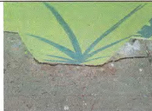
Foto 6: Columna en Movimiento. Demolición de concreto en base para relleno con fundición
