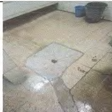
Foto 2: Bateria de baños para Hombres 4° a 6° Grado, Cambio de piso
