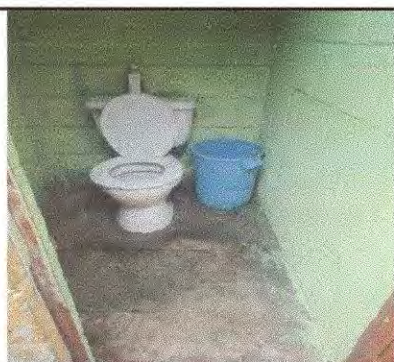
Foto 5: Baño profesores. Cambio inodoro y colocación de piso
