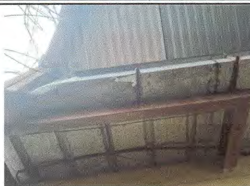
Foto 2: Arreglar canal en clase de la entrada
