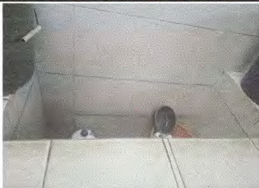
Foto 1: Bateria de baños para Hombres 4° a 6° Grado. Cambio de pileta por 2 lavamanos
