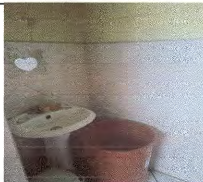
Foto 6: Baño de docentes 1, cambio de lavamanos
