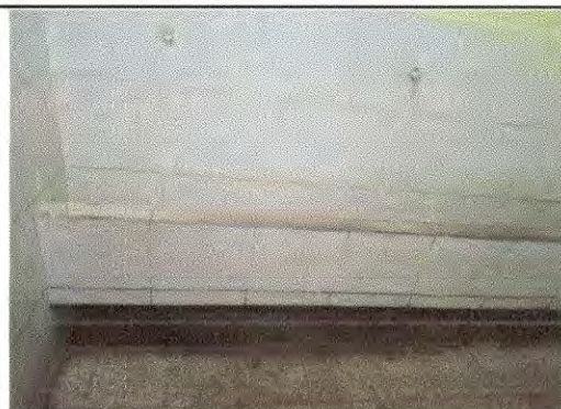
Foto 4: Bateria de baños para Hombres 4° a 6° Grado. Cambio de pileta por 2 mingitorios
