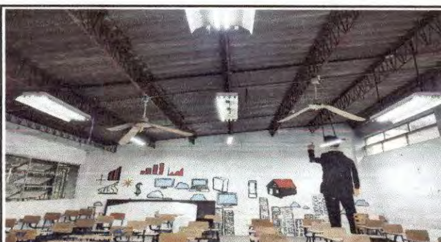
Foto 10: Salón 10 cambio de 3 láminas, relleno en tornillos y mantenimiento de canales
