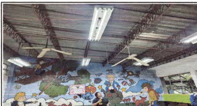
Foto 9: Salón 9 no hay cambio de láminas, solo mantenimiento de canales
