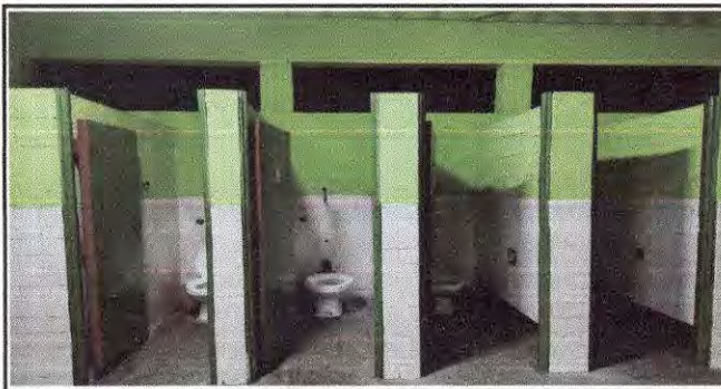
Foto 17: Baño de señoritas mantenimiento y reparación
