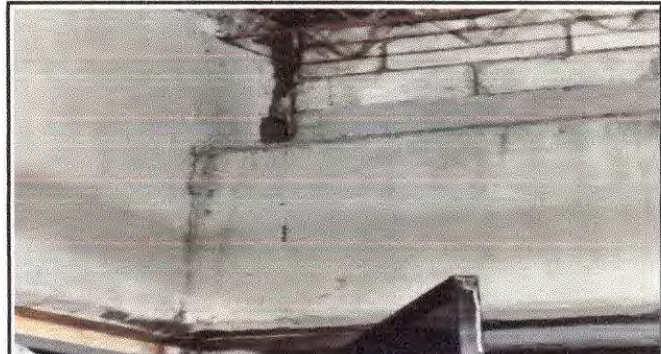
Foto 16: Salón de Práctica, reparación filtración vértice sobre la puerta
