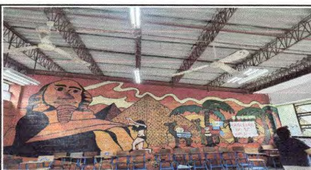
Foto 12: Salón 6to. Secretariado Bil. B, cambio de 4 láminas y mantenimiento de canales
