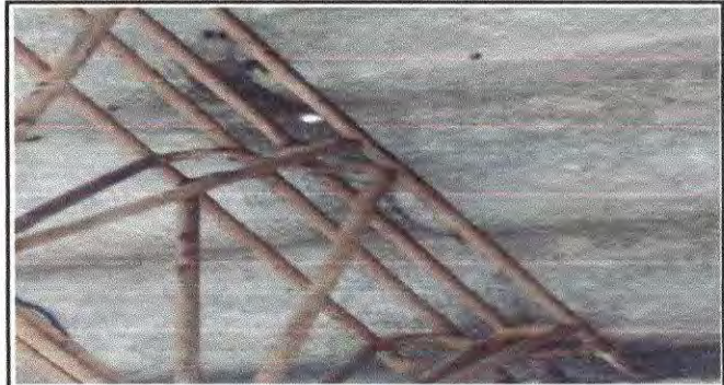
Foto 14: Salón 5to. Secretariado Of. A, cambio de 2 láminas y mantenimiento de canales
