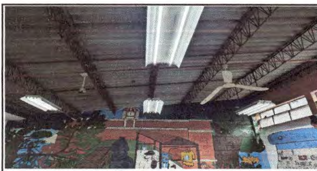
Foto 11: Salón 6to. Secretariado Bil. A, cambio de 4 láminas y mantenimiento de canales
