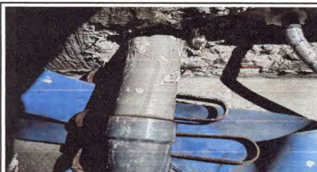
Foto 21: Baño de varones mantenimiento y reparación de tuberías
