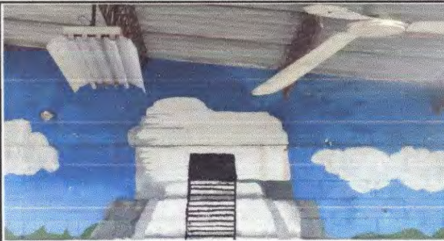
Foto 13: Salón 6to. Secretariado Bil. C, cambio de 2 láminas y mantenimiento de canales
