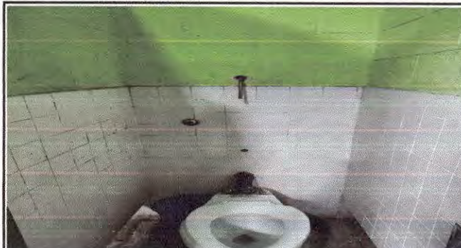
Foto 20: Baño de varones mantenimiento y reparación
