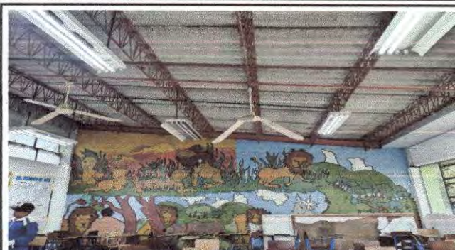
Foto 8: Salón 8 cambio de 4 láminas y mantenimiento de canales
