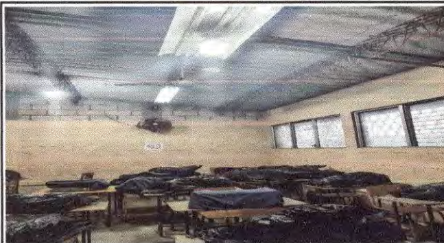
Foto 15: Salón de Práctica, cambio de 3 láminas y mantenimiento de canales
