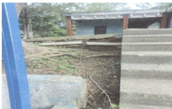
Foto 3: Reparación de sistema eléctrico en ducto de concreto
