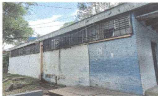
Foto 6: Aplicación de pintura exterior
