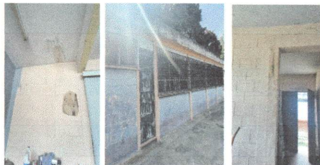
Foto 2: Pintura interior y exterior.
