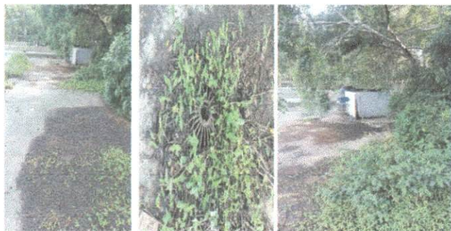
Foto1: Limpieza y habilitación de caída de agua, reposadera.
