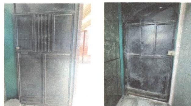
Foto 3: Remplazo y aplicación de pintura.
