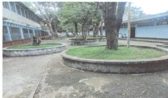
Foto 2: Limpieza, preparación y aplicación pintura
