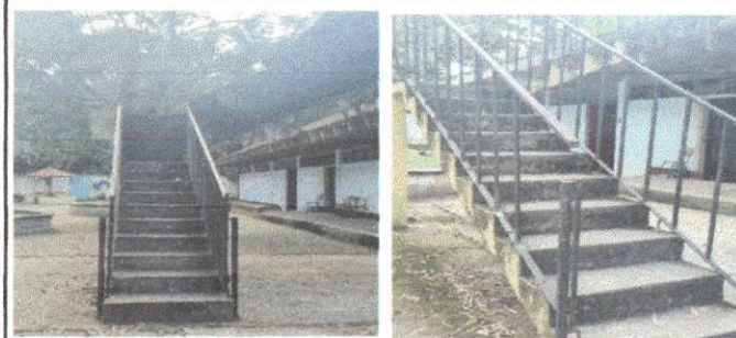
Foto 5: Reparación y aplicación de pintura de barandas de gradas.
