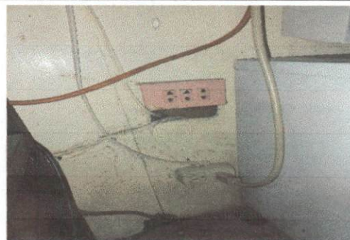
Foto 4: Cambio de sistema tomacorrientes y cableado.
