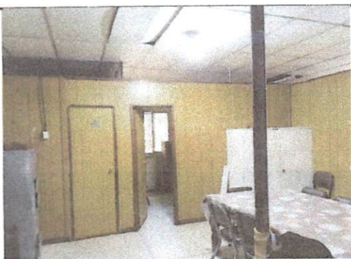
Foto 3: Pintura de puertas
