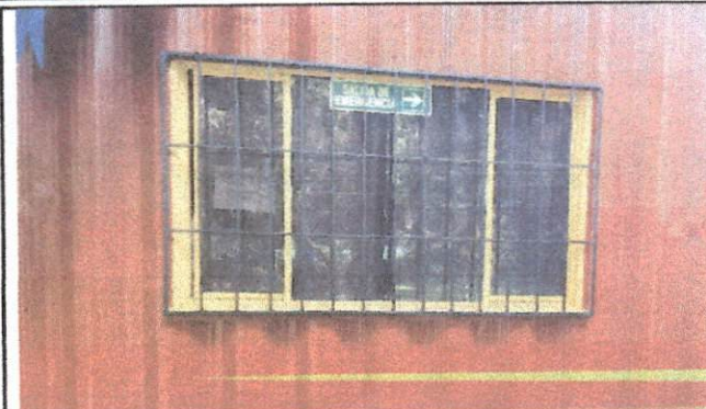
Foto 2: Pintura de Balcones
