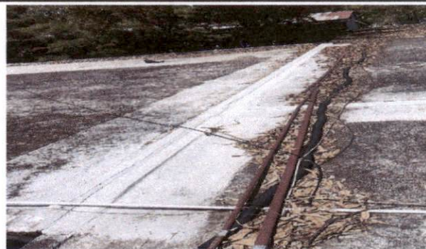
Foto 6: sección de loza a impermeabilizar
