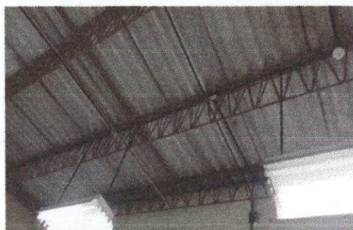
Cambio de lámina de duralita por lámina alucin calibre 26 legítima.
