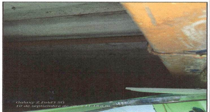
Bodega que funciona como salon de preprimaria, cambio de techo, mantenimiento de estructura metálica, lijado y pintura.
