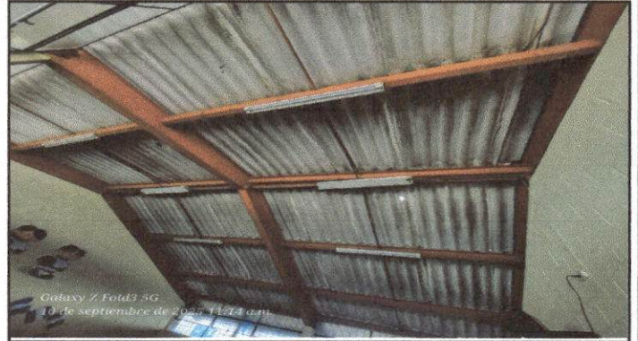
Salón 2 cambio de techo, matenimiento de estructura metálica, lijado y pintura.
