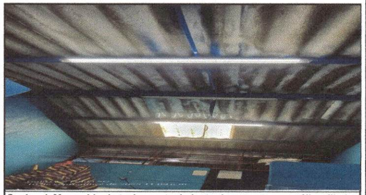
Cocina J. M cambio de techo, matenimiento de estructura metálica, lijado y pintura.
