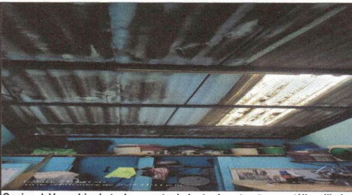
Cocina J. V cambio de techo, mantenimiento de estructura metálica, lijado y pintura.
