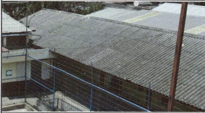
Techo de las tres aulas y bodega que esta en uso de aula. Foto de referencia toma de arriba
