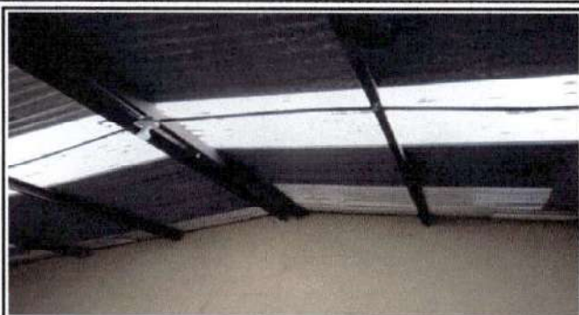
Foto1: Sustitucion de lamina existente por lamina troquelada calibre 26, en modulo 2
