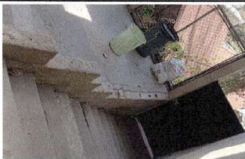
Foto 3: Reparación de muro perimetral en la entrada de EORM
