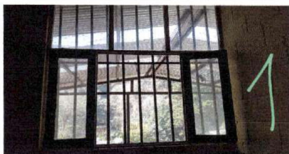
Foto 3: Sustitucion de ventana de la direccion.
