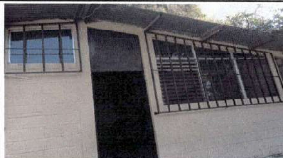
Foto 4: Sustitucion de lamina existente por lamina troquelada calibre 26 del modulo 1
