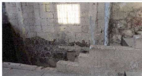
Foto 2: Reparación de muro perimetral en la entrada de EORM
