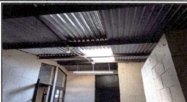
Foto 2: Sustitucion de lamina existente por lamina troquelada calibre 26 del pasillo del modulo 2
