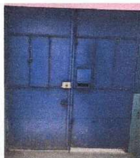
Foto 3: Módulo 11 mantenimiento de porton
