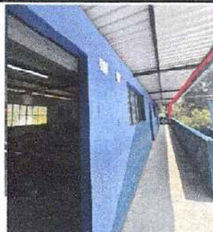
Foto 4: Sustitución de sistema automatizado de llenado de tinacos, Acá seguira la tubería
