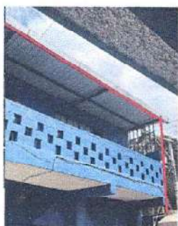
Foto 3: Sustitución de sistema automatizado de llenado de tinacos, Acá comenzaremos
