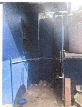
foto 6: Instalación de tinaco nuevo
