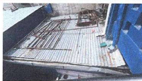
FOTO 6: Canal a Reparar
