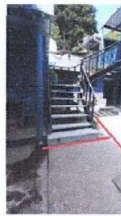
Foto 2: Reparación de red de drenajes y red de agua potable area a romper y luego a reparar acá se Continuará
