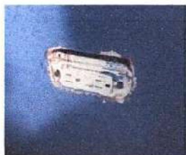
Foto 1: Reparación del sistema Eléctrico del grado de 6to.
