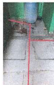
Foto 2: Piso de los Sanitarios lugar a nivelar y a colocar tubo que se conectará a drenaje acá se continuara (entrada)
