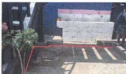
Foto 3: Sustitución de red de drenajes y red de agua potable area a romper y luego a reparar acá se terminará
