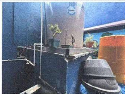
Foto 2: Sustitución de losa en la entrada principal donde se encuentra el tinaco
