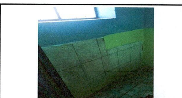
Foto 6: Sustitucion de azulejo en baño de niñas y niños.
