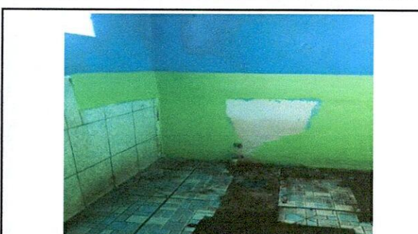
Foto 4: Sustitucion de azulejo en baño de niñas y niños
