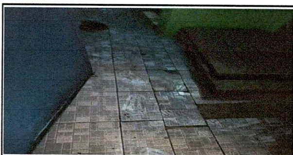
Foto 5: Sustitucion de piso en baño de niñas y niños.
