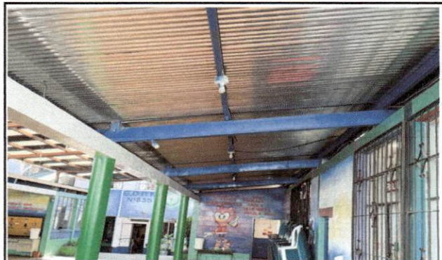
CORREDOR DE DONDE SE CAMBIAR EL CALEADO E ILUMINACIÓN
