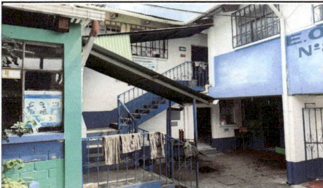
ESPACIO DONDE ESTÁN UBICADOS LOS BANOS QUE SE VAN A REPARAR
