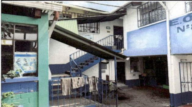
AREA DONDE SE ENCUENTRAN UBICADOS LOS BAÑOS QUE SE VAN A REPARAR
