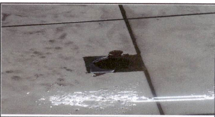
Foto 6: mantenimiento en drenaje en baño de maestros, ya que se mantiene reposada el agua porque no se va directamente en el drenaje
