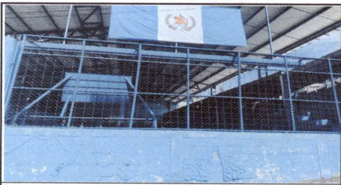
Foto 5: cambio de electro maya en parte frontal, esta floja y por la lluvias y el sol se ha deteriorado
