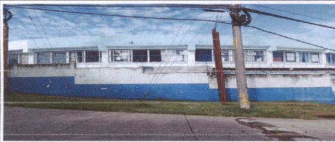
Foto 3: mantenimiento y aplicación de pintura a muros y paredes escuela exterior
