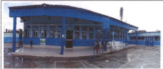
Foto 10: mantenimiento y aplicación de pintura balcones planta alta
