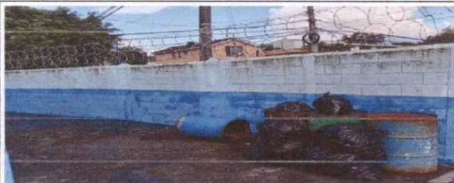
Foto 5: mantenimiento y aplicación de pintura a muros y paredes escuela exterior
