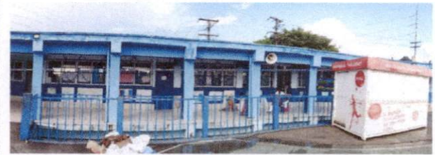
Foto 16: mantenimiento y aplicación de pintura a muros y paredes escuela exterior
