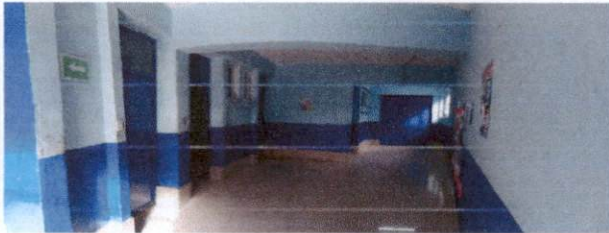
Foto13: mantenimiento y aplicación de pintura puertas planta baja
