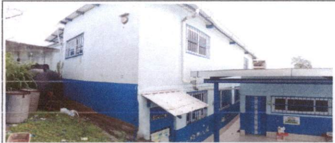
Foto 8: mantenimiento y aplicación de pintura a puertas y balcones planta baja
