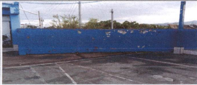
Foto 7: mantenimiento y aplicación de pintura a muros y paredes escuela exterior
