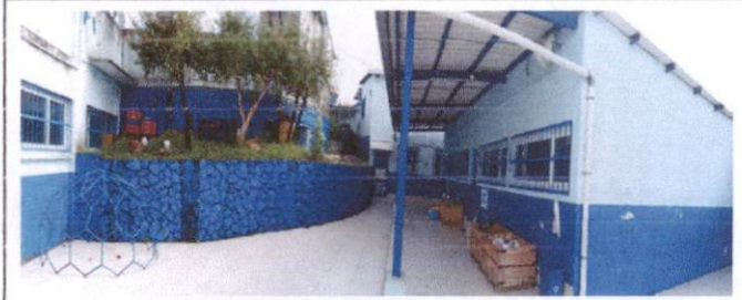
Foto 12: mantenimiento y aplicación de pintura balcones planta baja
