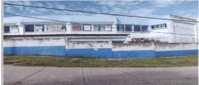
Foto 2: mantenimiento y aplicación de pintura a muros y paredes escuela exterior
