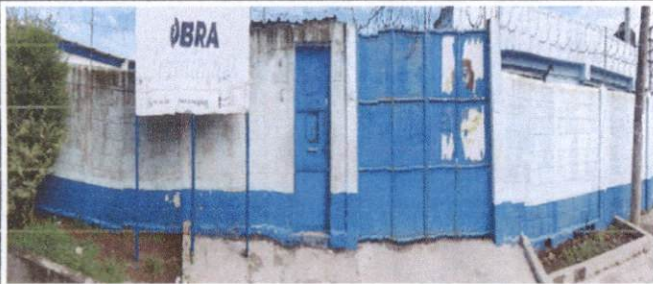
Foto1: mantenimiento y aplicación de pintura, portón principal planta alta
