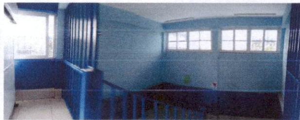
Foto 15: mantenimiento y aplicación de pintura baranda parte alta
