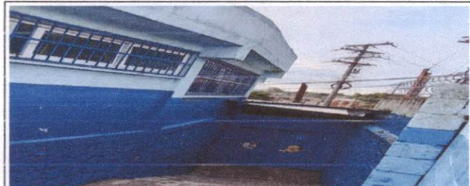
Foto 6: mantenimiento y aplicación de pintura portones planta baja
