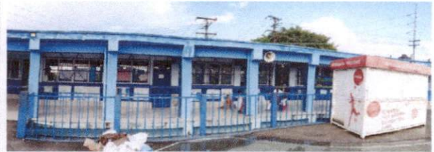
Foto 14: mantenimiento y aplicación de pintura baranda parte alta
