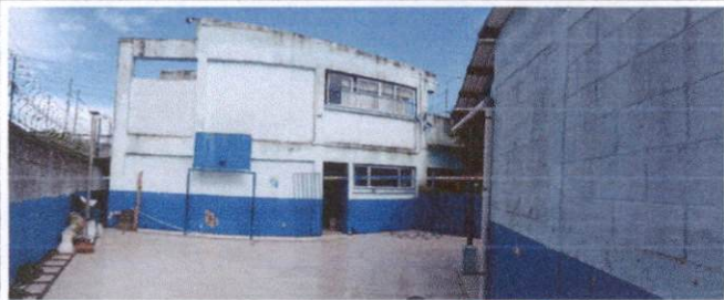
Foto 11: mantenimiento y aplicación de pintura puerta de reja planta baja
