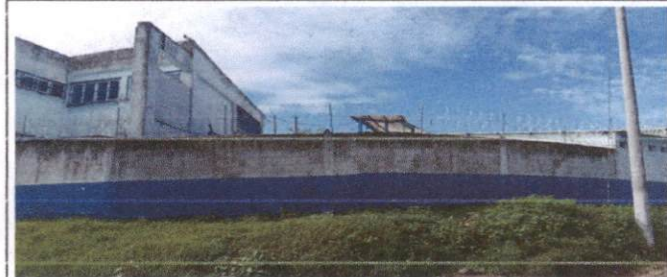
Foto 4: mantenimiento y aplicación de pintura a muros y paredes escuela exterior
