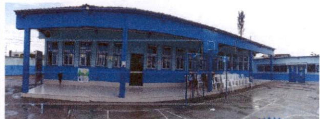
Foto 18: mantenimiento y aplicación de pintura muros y apredes de escuela exterior
