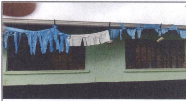
Foto 2: cambio de ventanas
