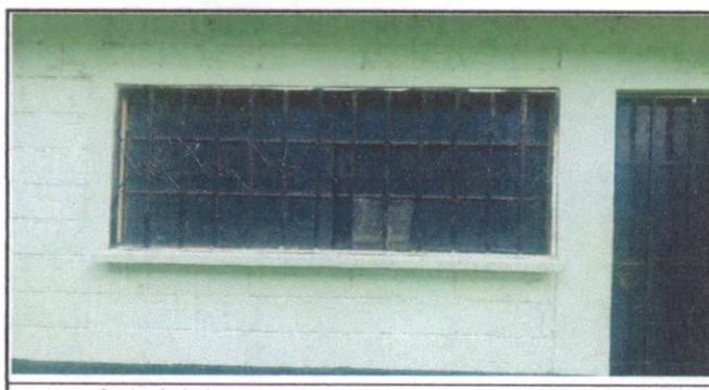
remosamiento de balcones
