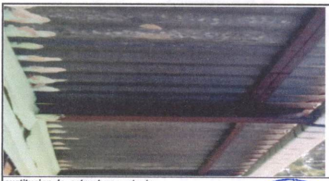
sustitucion de estructura portante
