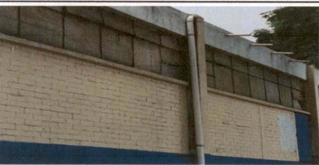
Foto 5: Cambio de ventanales de fibra de vidrio a vidrio. Con barrandal.
