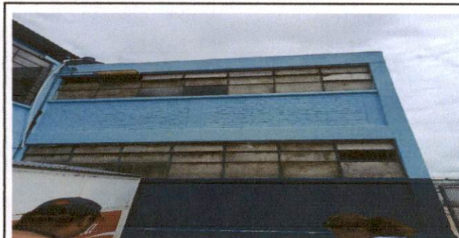
Foto 6: Cambio de ventanales de fibra de vidrio a vidrio. Con barrandal.
