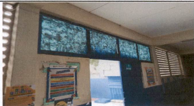
Foto1: Cambio de ventanales de fibra de vidrio a vidrio. Con barrandal.
