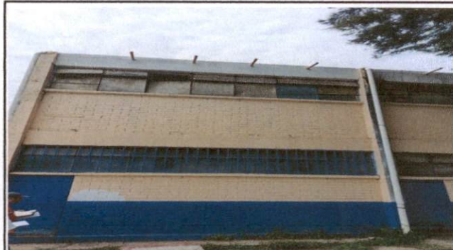
Foto 4: Cambio de ventanales de fibra de vidrio a vidrio. Con barrandal.
