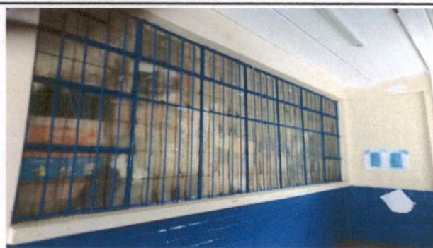
Foto 2: Cambio de ventanales de fibra de vidrio a vidrio. Con barrandal.
