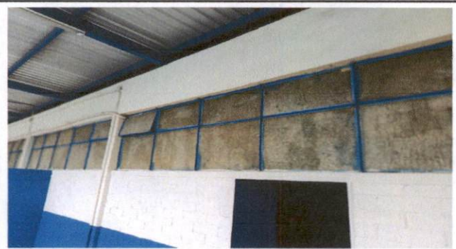
Foto 3: Cambio de ventanales de fibra de vidrio a vidrio. Con barrandal.
