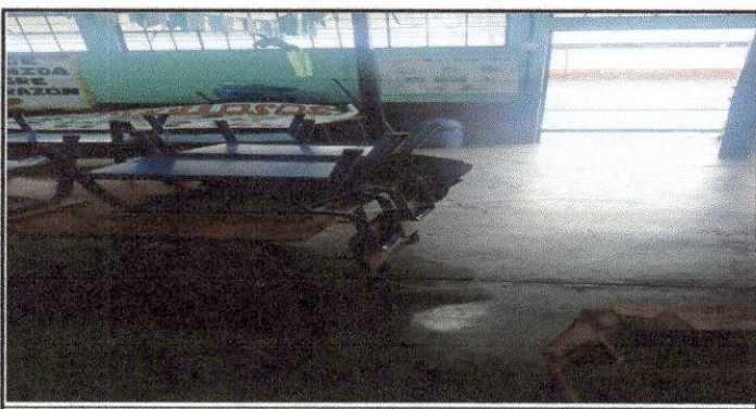
Foto 5: Salón de primer grado el cual cuenta con torta de concreto, se colocará piso para mejorar la calidad y presentación del espacio físico
