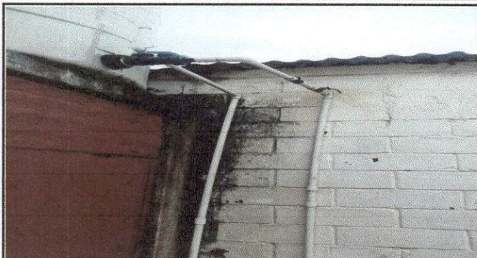
Foto 1: Reparación de la tubería de la red de drenajes que distribuye el agua desde el cisterna hacia los tinacos
