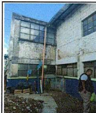
Foto 4: Patio Trasero: aplicación savieta, repello y aplicación de monocapa. Elaboración de plancha de concreto para area de tierra , para eviara la humedad en las paredes.
