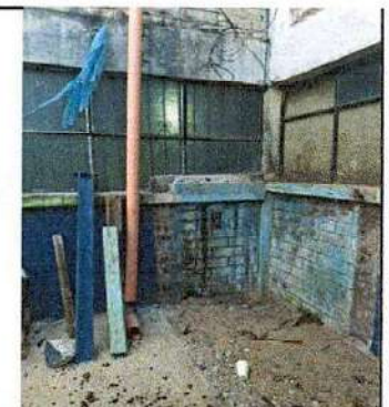
Foto 4: Patio Trasero: aplicación savieta, repello y aplicación de monocapa. Elaboración de plancha de concreto para area de tierra , para eviara la humedad en las paredes.
