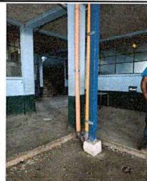
Foto 3: La tubería no conectada a los drenajes afecta a los estudiantes en sus actividades escolares
