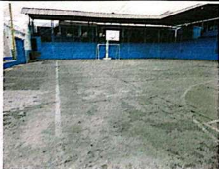
Foto 17: reparación de agujeros y marcado de líneas cancha grande
