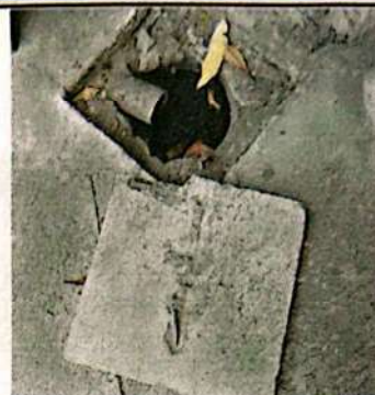
Foto 8: Mantenimiento de drenaje
