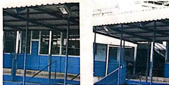
Foto: 20 Sustitucion de Reflectores en la cancha grande.
