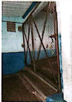
Foto1: Mantenimiento del segundo porton de ingreso
