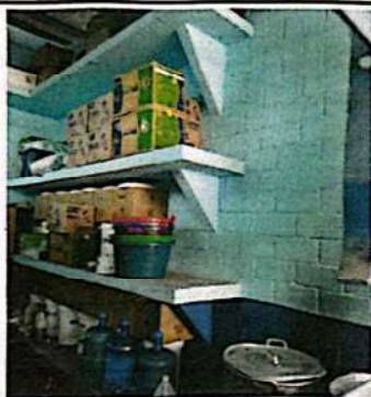
Foto: 19 Sustitucion y ampliación de azulejo en pared de cocina,cambio de piso de cocina.
