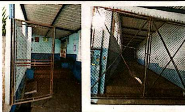
Foto 18: Mantenimiento de pintura de portones entrada
