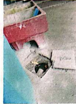
Foto 2: Mantenimiento de drenaje patio pequeño cerca de la pila
