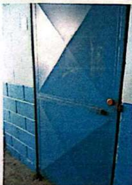
Foto 9: cambio de chapa
