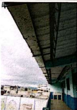
Foto 5: Instalacion de canales en el patio grande segundo nivel frente a salones de quinto grado
