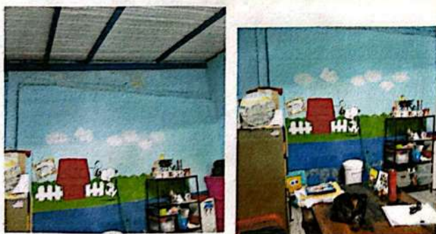
Foto 11: Impermeabilizar pared de salón a la par de dirección
