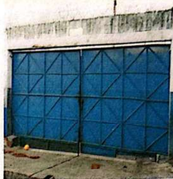
Foto 14: reparar y pintar porton frente a graderio
