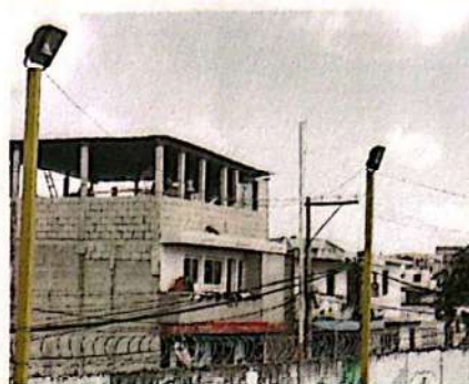
Foto: 20 Sustitucion de Reflectores en la cancha grande.
