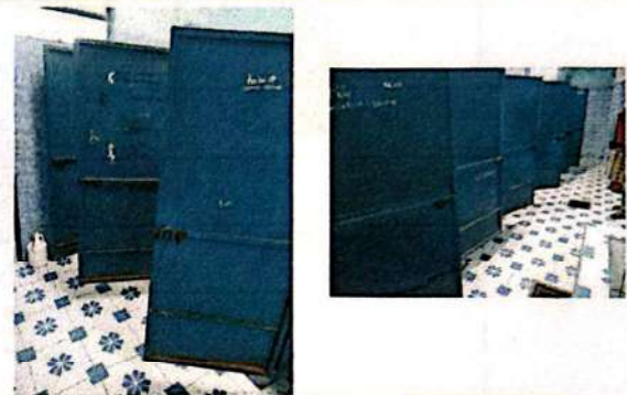
Foto 4: Mantenimiento de puertas de baños de niños y niñas
