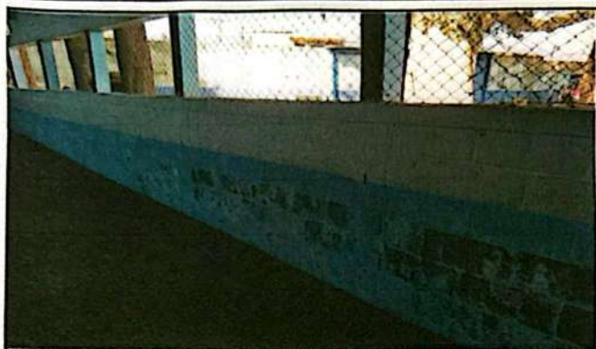
Foto 7: Pintura del corredor de ingreso
