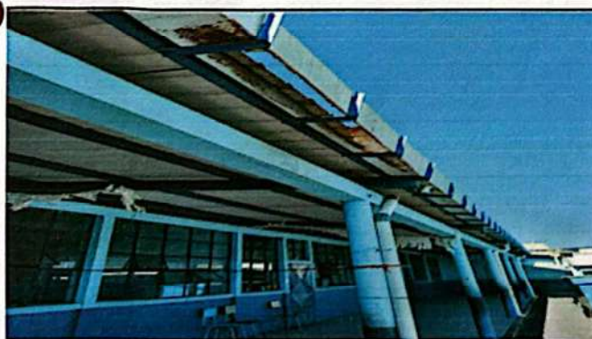
Foto 5: Instalación de Canales en el patio grande y pequeño.
