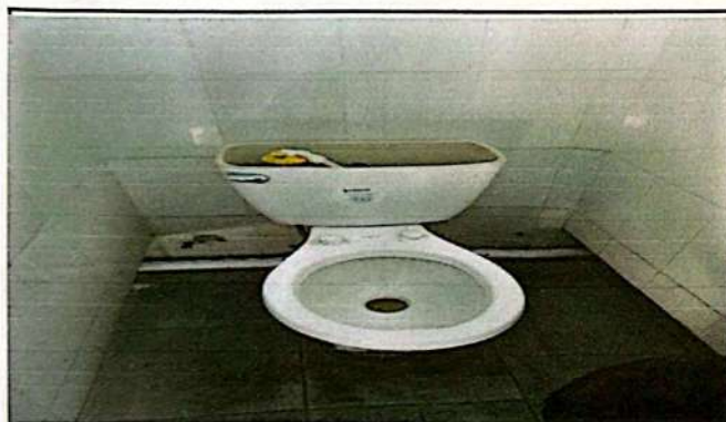
Foto 3: Instalación de taza sanitaria en el baño de niñas parte primer nivel
