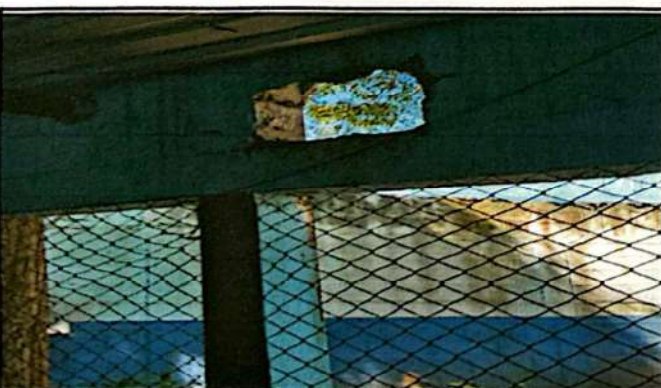
Foto 11: Reparación de pared con cernido ubicada en el corredor de ingreso de los niños y niñas.
