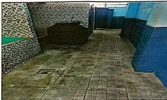
Foto 4: Instalación de Azulejo en muros de Baños de niños y niñas (Parte Azul).
