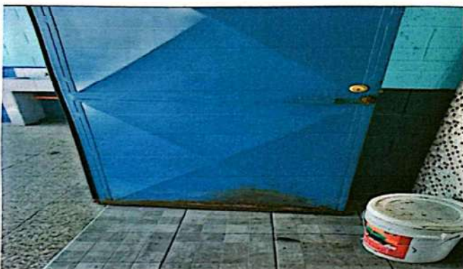
Foto 9: Mantenimiento a 6 puertas grandes de baños de niñas y niños.
