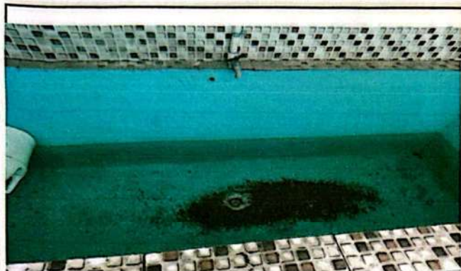
Foto 13: Mantenimiento de depósito de agua (pilas) de baños de niños y niñas.
