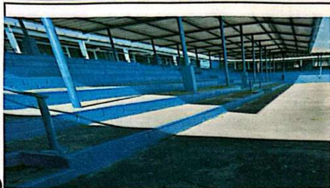
Foto1: Pintura de gradas de la cancha (Patio grande)
