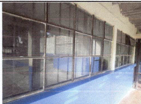
Foto 4: Desmontaje de ventanas de metal para instalación de ventanas de pvc color blanco + vidrio claro de 5mm-perfil 600.
