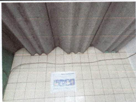
Foto 9: Cernido, remolineado donde se levantará para ajustar paredes.
