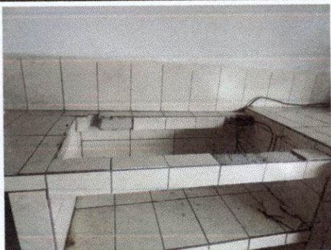
Foto 7: Instalación de azulejo blanco 20x20, como salpicadero 0.60 mts de altura.
