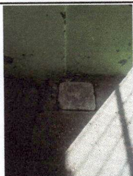
Foto 11: Limpieza de caja de registro pluvial junto a la pila exterior.
