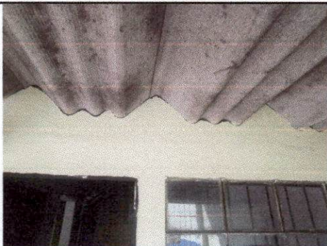
Foto 3: Demolición de formas curvas de la pared parte frontal y posterior y canal .
