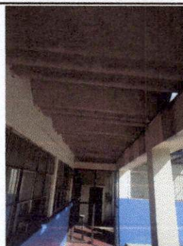
Foto 2: Desmontaje de lamina duralita para instalación de lamina troquelada esmaltada blanca calibre 26.
