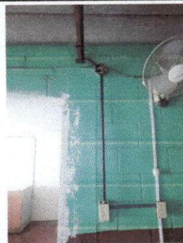
Foto 8: Desmontado de lamparas y tuberías existentes para instalación de lamparas eléctricas nuevas, cableado, entubado eléctrico, tubos y cables nuevos.
