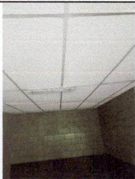
Foto 1: Desmontaje de lamina duralita y cielo falso de duroport para fabricación e instalación de estructura de techo de metal.
