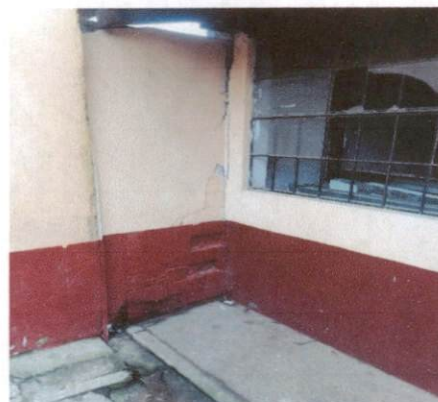
foto 10. Muro de contención
