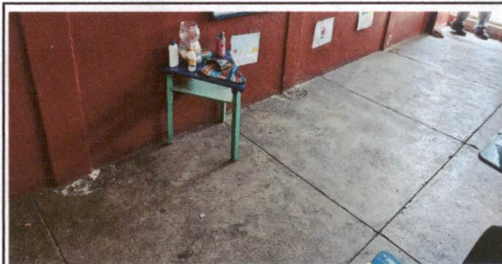
Foto 6: AULA 4 PISO DE GRANITO TERCERO "B"
