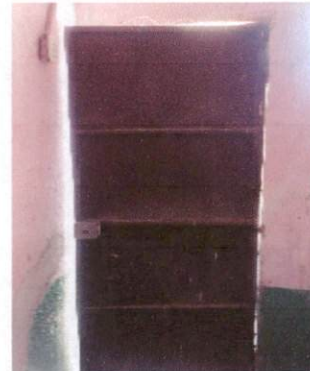
Foto 2: CORTE DE PUERTAS A NIVELACIÓN DE PISOS (ATRÁS)
