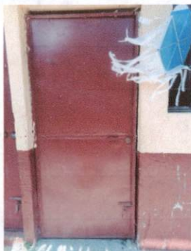
Foto 1: CORTE DE PUERTAS A NIVELACIÓN DE PISOS (FRENTE)
