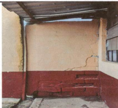
Foto 9: MURO DE CONTENCIÓN
