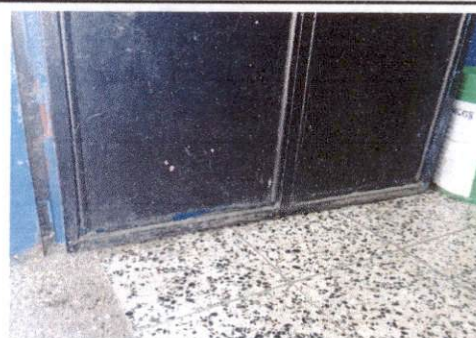
Foto 4: Mantenimiento de puertas por deterioro salón 7.
