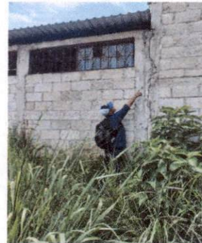
Foto 8: Reparación grieta por sismo salón 10.
