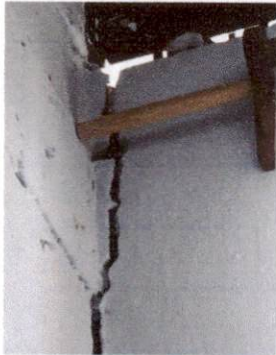
Foto 7: Reparación grieta por sismo salón 3.
