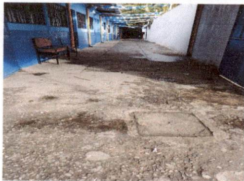
Foto1: Cambio de Losa por deterioro por la lluvia
