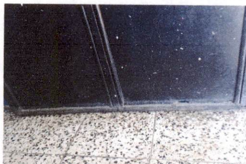
Foto 5: Mantenimiento de puertas por deterioro salón 7.
