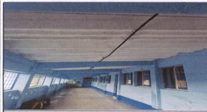
Foto 5: Sustitución de cubierta de Lámina duralita en corredor por Lámina Troquelada
