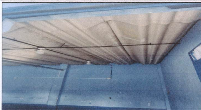
Foto1: Desmontaje de sistema eléctrico en aulas
