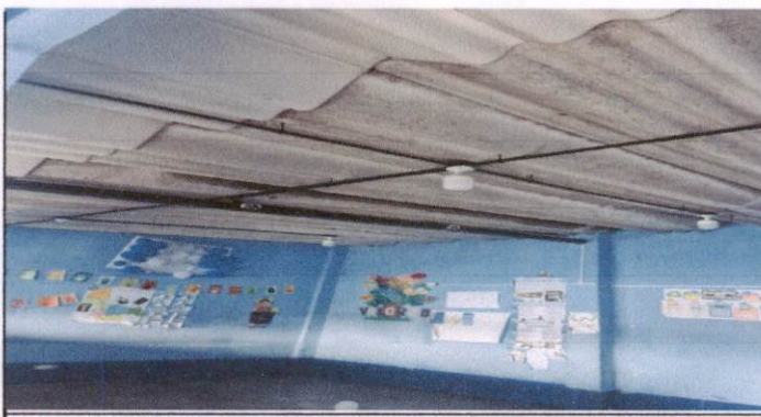
Foto 6: Sustitución de cubierta de Lámina duralita en aulas por Lámina Troquelada
