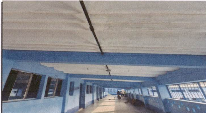
Foto 4: Sustitución de cubierta de Lámina duralita en corredor por Lámina Troquelada
