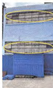
Foto 2: Reparación de ventanas No.1 y ventana No. 2 e instalación de balcones.
