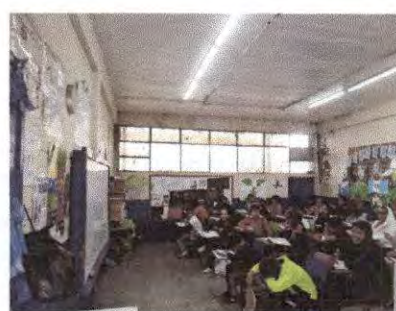
Foto 6: Ventana No.6 con balcón e impermeabilización de pared y pintura de aula.
