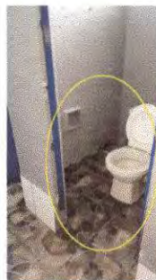
Foto 8: Servicios Sanitarios, reparación de paredes, pintura y nivelación de puertas.
