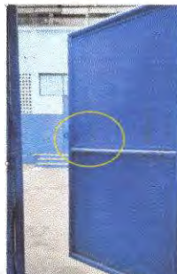
Foto 12: Mantenimiento a portón, colocación de chapa.
