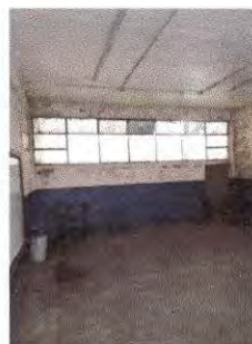
Foto 4: Ventana No.4 con balcón e impermeabilización de pared y pintura de aula.
