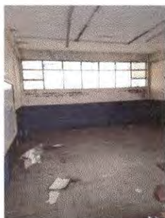
Foto 3: Ventana No.3 con balcón e impermeabilización de pared y pintura de aula.
