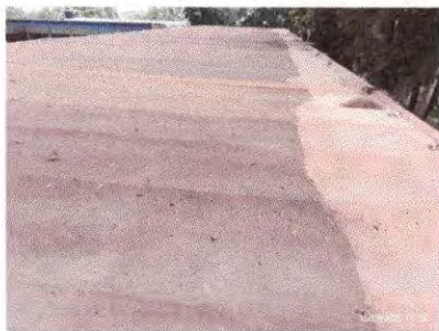
Foto1: Impermeabilización de losa.
