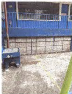
Foto 7: Ventana No.7 con balcón e impermeabilización de pared y pintura de aula
