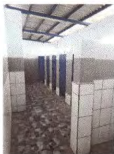
Foto 9: Servicios Sanitarios, reparación de paredes, pintura y nivelación de puertas.
