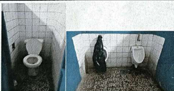
Foto 5: Sustitución de inodoros + urinales.
