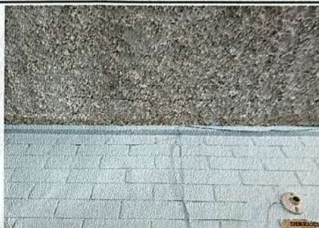
Foto 2: Reparación de grietas.
