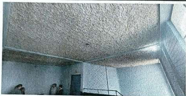
Foto1: Reparacion de pañuelos + impermeabilizante.
