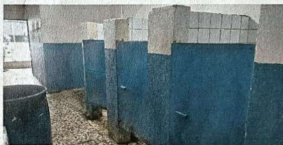
Foto 4: Sustitución de puertas de metal.
