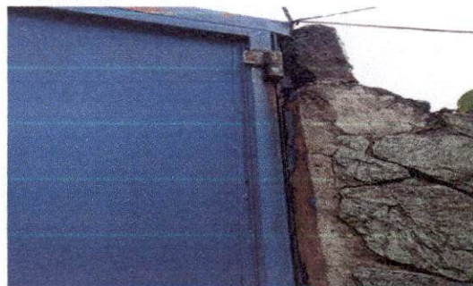
Foto 8: Reparacion y mantenimiento porton de la entrada de la escuela
