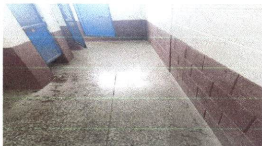
Foto 1 Cambio de Piso en 12 baños
