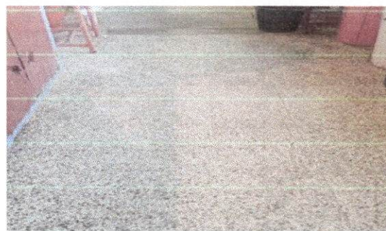
Foto 2: Cambio de Piso en la Cocina
