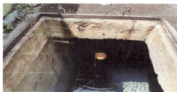
Foto 6: Parte interior del cisterna
