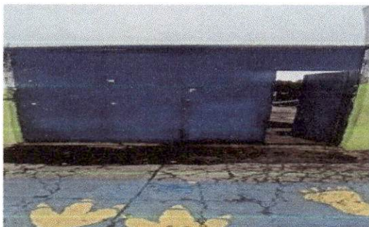
Foto 10 Mantenimiento porton lado exterior las medida son 2.65 de alto y 2.60 de ancho
