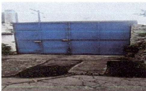
Foto 11. Mantenimiento del Portón lado interior
