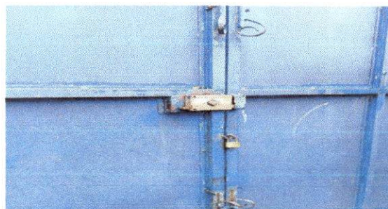
Foto 11 Arreglo chapa porton
