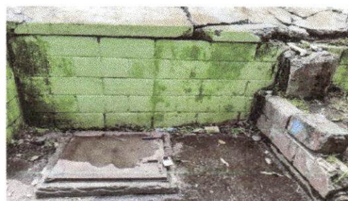
Foto 4: Mantenimiento Cisterna ( parte exterior del cisterna)
