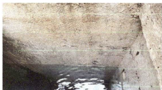
Foto 5: Parte interior del Cisterna (paredes) El cisterna mide profundidad 2.90 de ancho mide 2.40 y de largo 2.50
