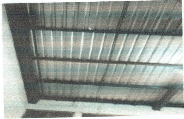
REPARACION DE GOTERAS
