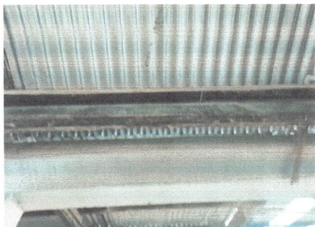
SUSTITUCION DE CANAL Y SOPORTES
