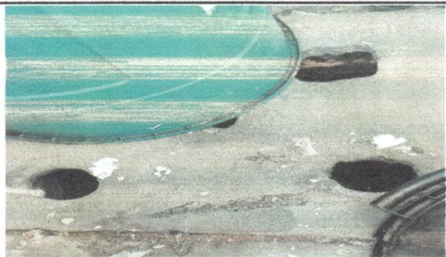
COLOCACION DE RENDIJAS EN DESAGUES
