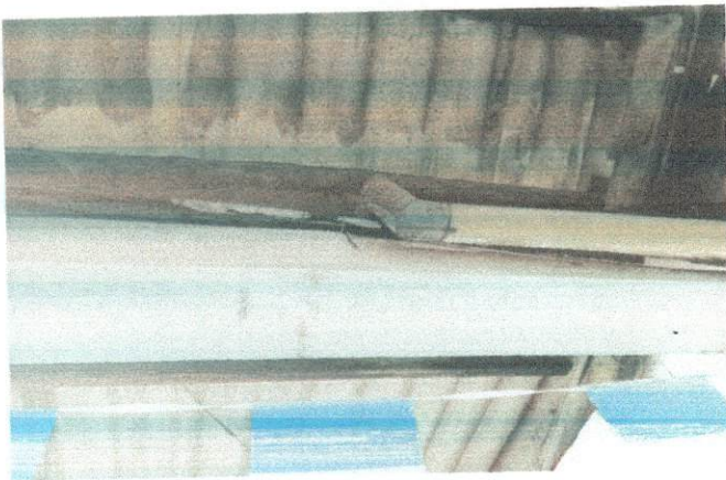
REPARACION DE CANALES DE CLASES
