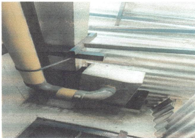
REPARACION DE TUBOS DE AGUA
