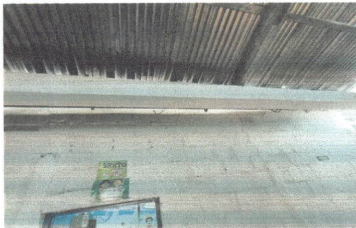
REPARACION DE FILTRO REPARACION DE FILTRACION DE AGUA EN PARED Y LAMIN
