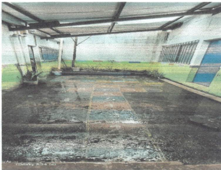
REPARACION DE DRENAJES EN PATAIO
