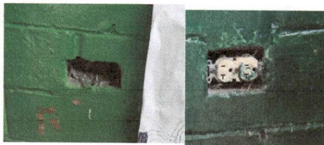
Foto 6: Nivel 2 se cambiará los interruptores en otra posición
