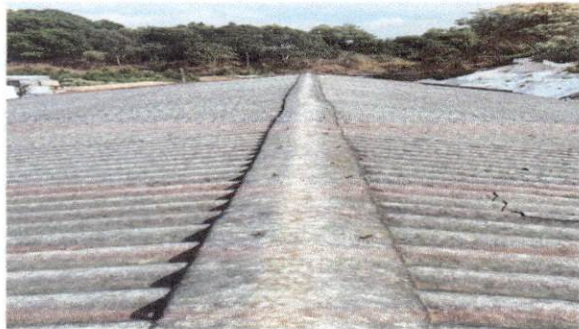
Foto 1: Techo en módulo C, desmontaje de techo de duralita, cambio por lámina troquelada de calibre 26.
