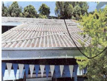
Foto 4: Techo gradas, módulo C cambio de techo de duralita por lámina calibre 26.
