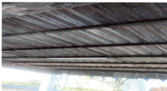
Foto 5: Techo gradas, módulo C, mantenimiento lijado y pintura de costaneras.
