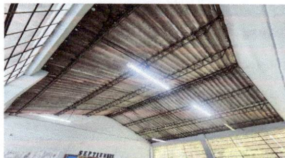
Foto 6: Techo, módulo C, mantenimiento lijado y pintura de joist.
