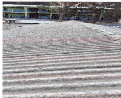
Foto 2: Techo módulo C, sustitución de techo duralita por lámina troquelada de calibre 26.
