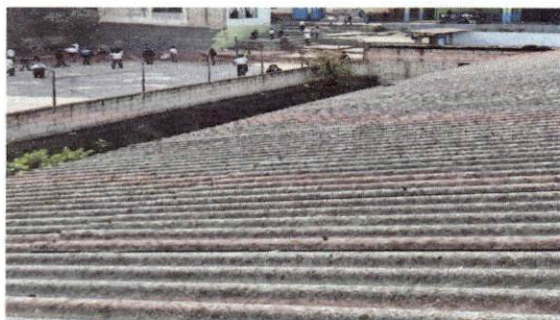
Foto 3: Techo en módulo C, desmontaje de techo de duralita, cambio por lámina troquelada de calibre 26.
