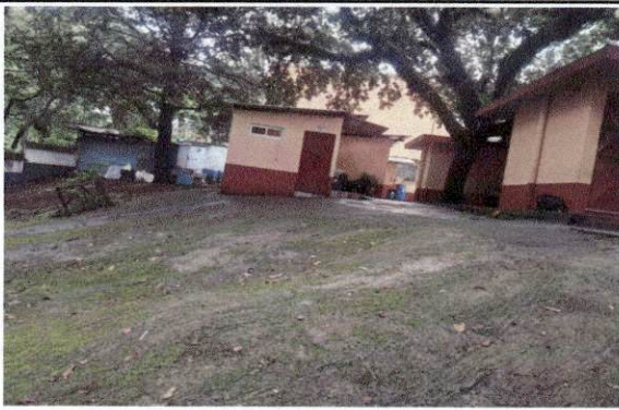
2. LOSA DE PATIO: MEJORAMIENTO DE PATIO PARA EVITAR ACCIDENTES Y MEJORAR LA SEGURIDAD DENTRO DEL ESTABLECIMIENTO
