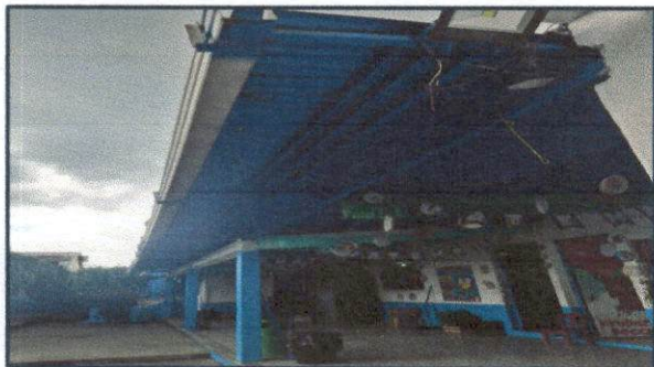
Foto1: sustitución de lámina en aula No. 1 y 2 de módulo 1
