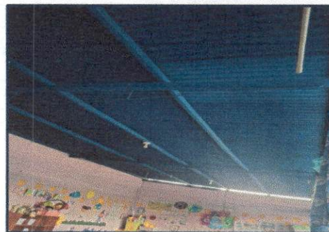
Foto 2: Sustitución de lámina en aula No. 3 de módulo 1
