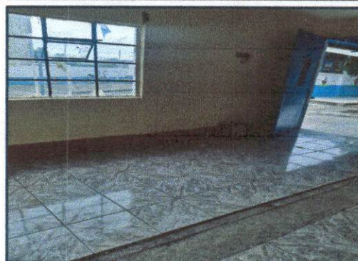
Foto 4: Sustitución de piso en salon de maestras en el módulo 1
