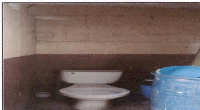
Foto 3: cambio de sanitarios de niños y niñas por baños industriales
