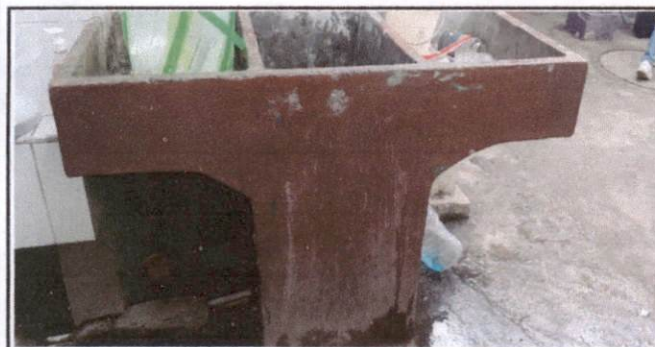
Foto 5: cambio de pila por deterioro de la antigua
