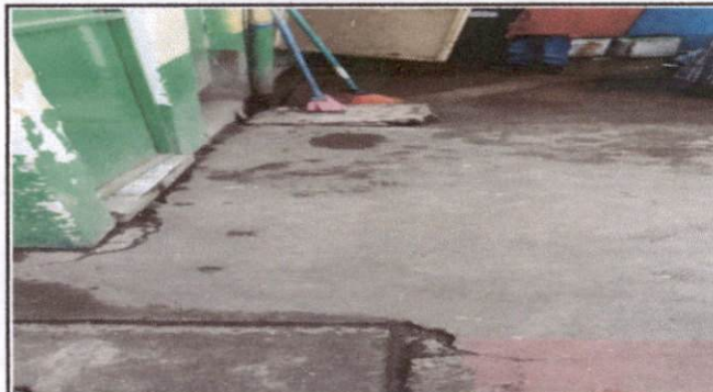
Foto 2: mantenimiento de drenaje para habilitacion de sanitarios
