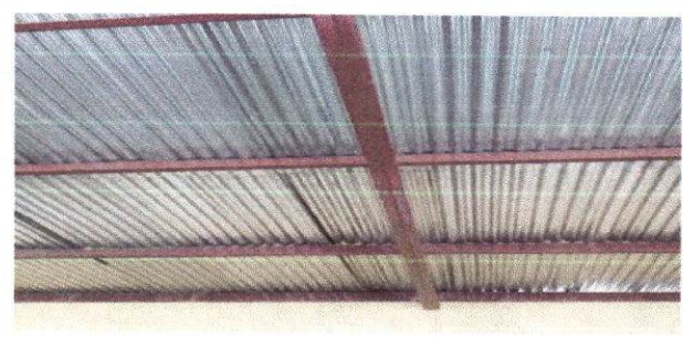
Foto 6: Estructura portante 4 aulas
