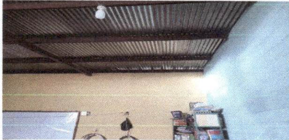
Foto 1: Cambio de techo en las 4 aulas de Preprimaria
