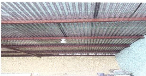
Foto 5: Estructura portante 4 aulas
