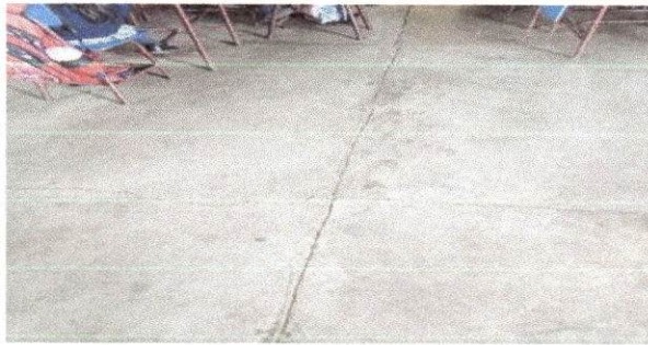
Foto 3: Cambio de piso Aula 2
