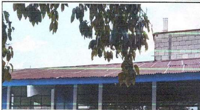
Foto1: Vista general de la cubierta de lamina en el modulo de Direccion, Tres Aulas y Servicios Sanitarios.
