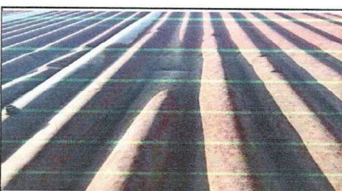
Foto 6: En fotografia se observa lamina doblada y tornillos faltantes ya que por el tiempo la lamina termino su vida util, lo que provoca filtracion y humedad en muros y piso del aula.
