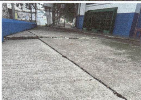
Foto 5: Se observa desnivel de producido por la humedad que persiste en el área.
