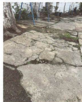
Foto 2: Levantamiento de torta.
