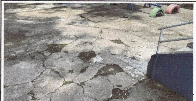
Foto 6: Levantamiento de torta en el área de juegos.
