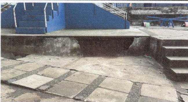
Foto 5: Repello caído en el talud del área superior de juegos
