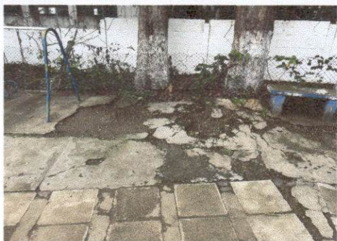
Foto1: Se aprecia el desnivel del terreno debido a las raíces presentes.
