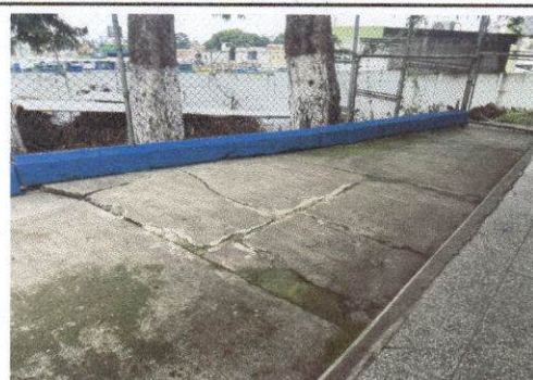
Foto 6: Debido a la humedad se ha levantado la torta y se ve un desnivel considerable en el cerco de separación que lo ha levantado.
