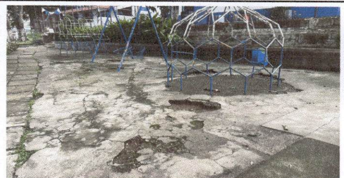
Foto 4: Levantamiento de torta en el área de juegos presenta tierra.
