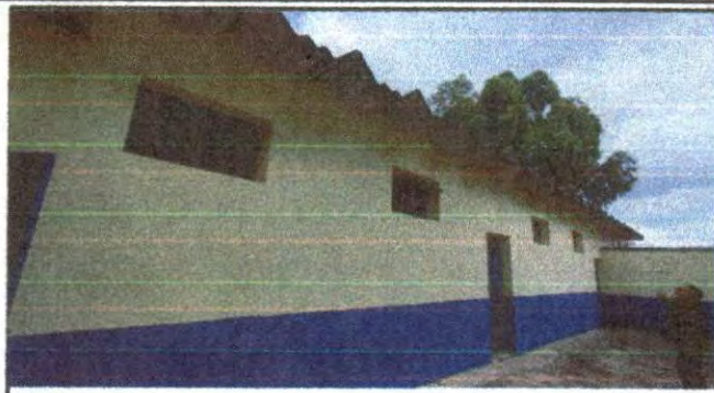
Foto 2: Parte de atrás de las 2 aulas que se cambiará el techo
