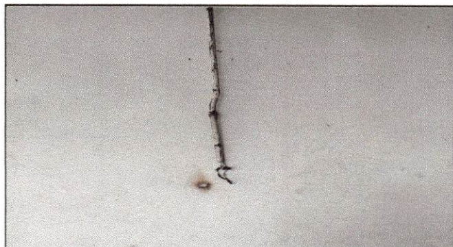
Foto 4: mantenimiento de cable de electricidad, por corto circuito.
