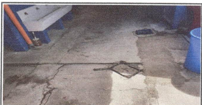
Foto 6: Mantenimiento y limpieza a red de drenajes, cajas de registro y reposaderas, así como la sustitución de reposadera por mal funcionamiento
