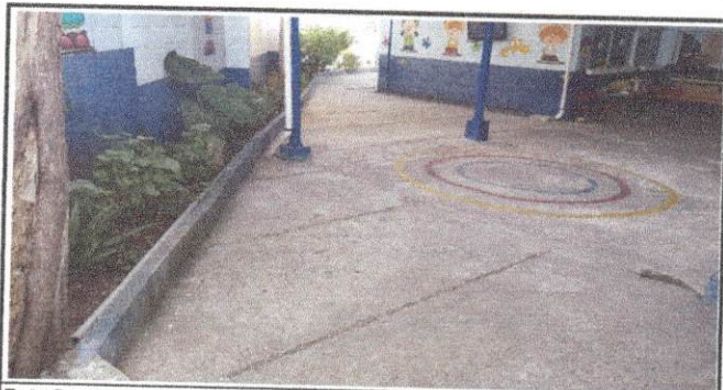
Foto 5: Sustitución de piso de torta de concreto incluye: demolición de losa de patio y fundición de la nueva con electromalla, ya que en el tiempo de lluvia colapsan los drenajes
