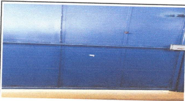
Foto 3: mantenimiento a portones de ingreso (lijado, sujeciones y pintura a dos manos)
