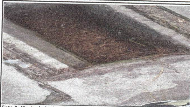
Foto 2: Mantenimiento y limpieza a red de drenajes, cajas de registro y reposaderas, así como la sustitución de reposadera por mal funcionamiento
