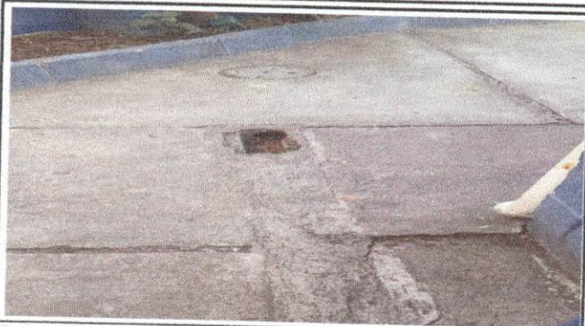
Foto 1: Mantenimiento y limpieza a red de drenajes, cajas de registro y reposaderas, así como la sustitución de reposadera por mal funcionamiento
