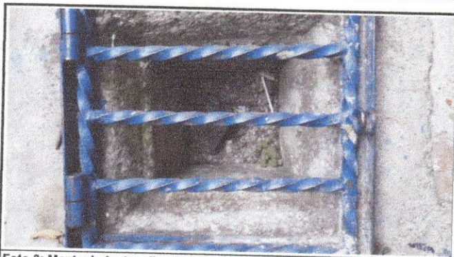
Foto 3: Mantenimiento y limpieza a red de drenajes, cajas de registro y reposaderas, así como la sustitución de reposadera por mal funcionamiento
