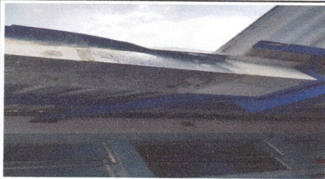
Foto1: Mantenimiento a canales y bajadas de agua pluvial, incluye limpieza, revisión de juntas, mantenimiento a bajadas de agua pluvial y reparación para evitar filtraciones o fugas de agua
