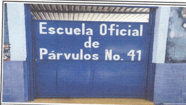
Foto 2: Mantenimiento a portones de ingreso (lijado, sujeciones y pintura a dos manos)
