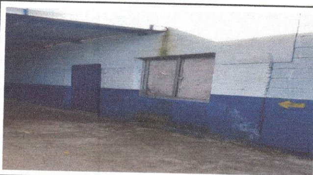
Foto 4: Resanamiento de pared, incluye limpieza, impermeabilización y aplicación de pintura
