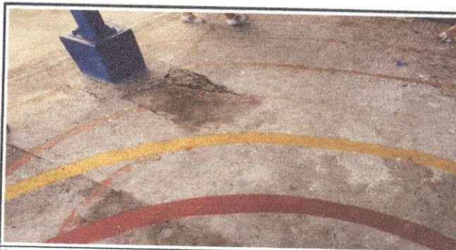
Foto 6: Sustitución de piso de torta de concreto incluye: demolición de losa de patio y fundición de la nueva con electromalla, por encontrarse en mal estado, existiendo un riesgo para los niños
