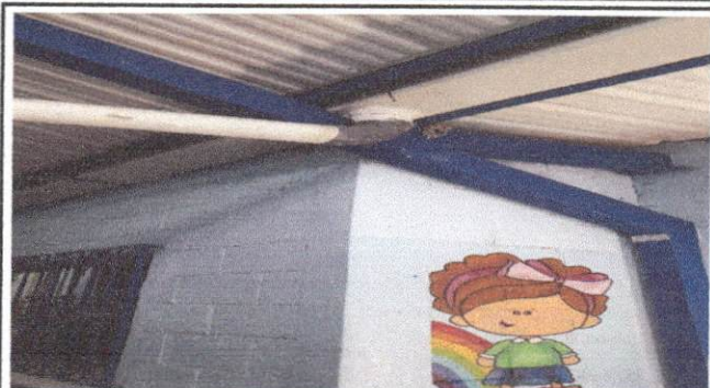
Foto 2: Mantenimiento a canales y bajadas de agua pluvial, incluye limpieza, revisión de juntas, mantenimiento a bajadas de agua pluvial y reparación para evitar filtraciones o fugas de agua
