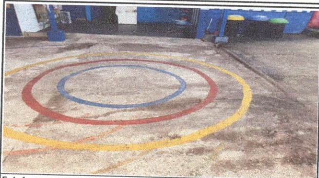
Foto 1: Sustrucción de piso de torta de concreto incluye: demolición de losa de patio y fundición de la nueva con electromalla, ya que existe un desnivel que ocasiona un riesgo para los niños, y que en el tiempo de lluvia colapsen los drenajes
