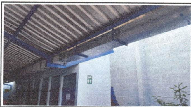
Foto 4: Mantenimiento a canales y bajadas de agua pluvial, incluye limpieza, revisión de juntas, mantenimiento a bajadas de agua pluvial y reparación para evitar filtraciones o fugas de agua
