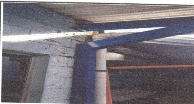
Foto 6: Resanamiento de pared, incluye limpieza, impermeabilización y aplicación de pintura
