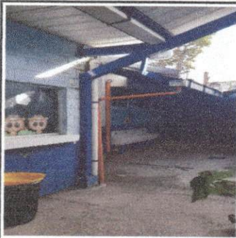
Foto 3: Mantenimiento a canales y bajadas de agua pluvial, incluye limpieza, revisión de juntas, mantenimiento a bajadas de agua pluvial y reparación para evitar filtraciones o fugas de agua
