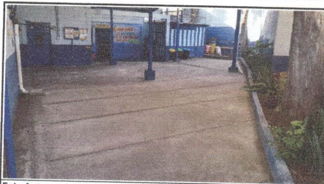
Foto 4: Sustitución de piso de torta de concreto incluye: demolición de losa de patio y fundición de la nueva con electromalla, ya que existe un desnivel que ocasiona que en el tiempo de lluvia colapsen los drenajes
