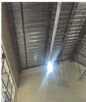
Foto1: Cambio de lamina duralita por lamina alucink troquelada calibre 24 en 2 aulas, y pintar la estructura.
