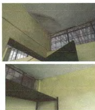
Foto 4: Loza de cocina hacerle el pañuelo e impermeabilizar , sanear el area.En paredes de cocina exterior impermeabilizar 26.40metros cuadrados
