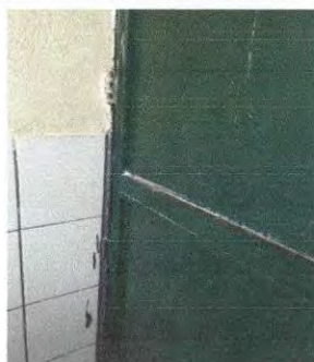
Foto 5: Reparar y pintar la puerta de entrada de cocina
