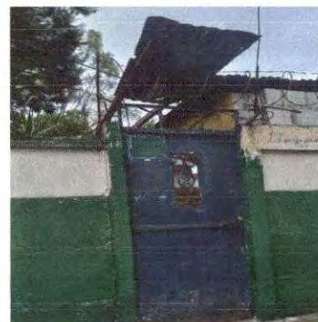
Foto 10: cambio de puerta de metal por puerta de metal con su techo para protección
