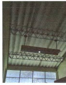
Foto 2: Cambio de lamina duralita por lamina alucink troquelada calibre 24 en 2 aulas, y pintar la estructura.
