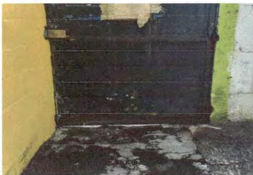
Foto 11: sustitucion detorta de concreto entrada principal puerta peatonal
