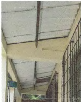
Foto1: Cambio de lamina duralita por lamina alucink troquelada calibre 24 en 2 aulas, y pintar la estructura.
