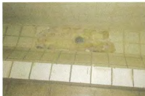
Foto 8: Anulación de canal de orina e instalar 3 migitorios , e instar 13 metros de azulejo
