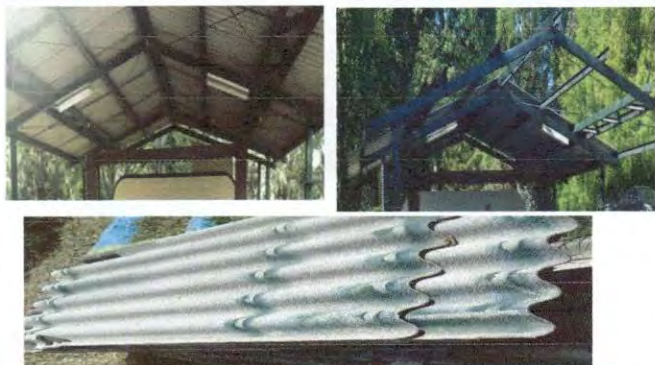
Foto7: Cambio de lamina duralita por lamina alucink troquelada calibre 20 en pergola
