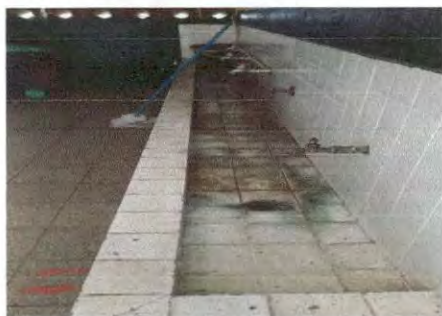
Foto 9:Cambio de cierre de agua, levantado de 5metros por 10cm. Cambio de azulejos por otro.
