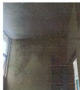
Foto 4: Loza de cocina hacerle el pañuelo e impermeabilizar , sanear el area.En paredes de cocina exterior impermeabilizar 26.40metros cuadrados
