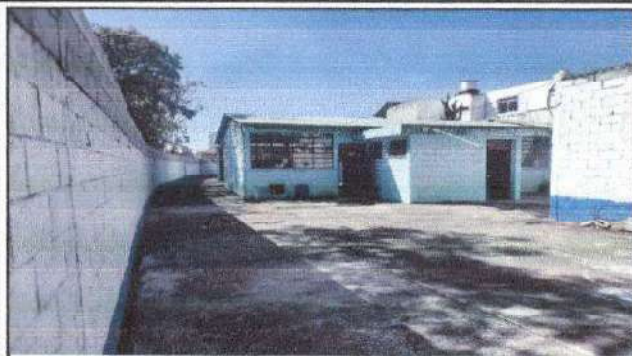
Foto 1: Sustitucion de pintura de los modulos de direccion, aula de cocina, bodega, aula de cuatro años y aula de computacion.
