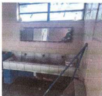
Foto 9: Sustitución de azulejo en baños de niñas y niños y chorros de 1/2 en lavamanos.
