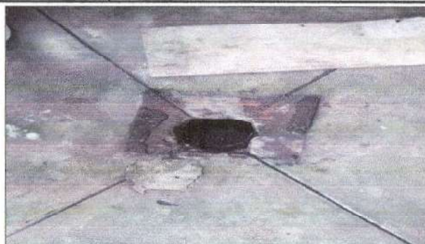
Foto 2: Reparacion de drenaje en baño de niña y niños.
