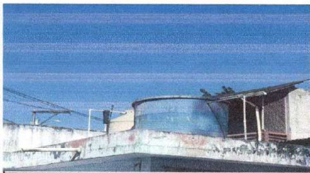
Foto 3: Sustitucion de tinacos.
