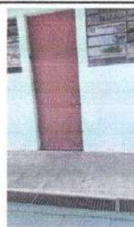
Foto 12: Sustitución de puerta de bodega
