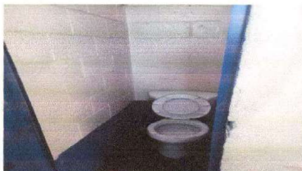
Foto 4: Sustitucion de inodoros en baños de niñas y niños.
