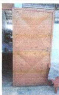
Foto 11: Sustitución de puerta de cocina.
