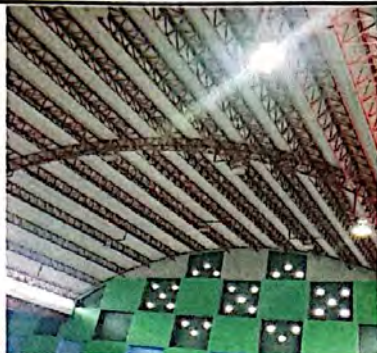
Foto 1: Desmontaje e instalación de luminarias tipo campana.
