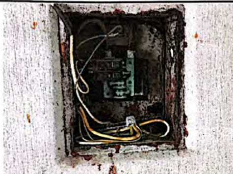
Foto 3: Instalación de tablero de 14 polos, 120 - 240, 8 flipones.
