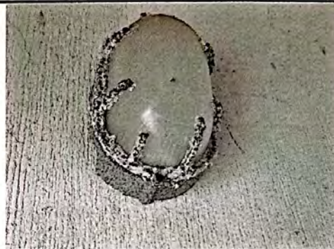
Foto 4: Colocación de lámparas en bodega de piscina.
