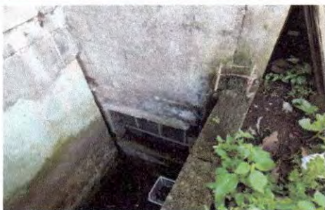
Reparación y refuerzo de la cuneta No.1 Ya que se encuentra obstruida y el agua desemboca en las paredes de la cocina
