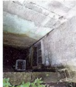
Reparación del muro perimetral No.2 debido a la humedad, pequeños deslaves de tierra y por el ripio que los vecinos que mantienen en el área
