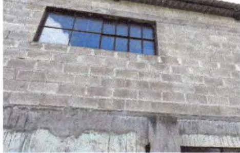
Reparación de cernido y repello en pared exterior No.1 por grietas provocadas por humedad
