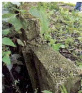
Reparación del muro perimetral No.1 debido a la humedad, pequeños deslaves de tierra y por el ripio que los vecinos que mantienen en el área
