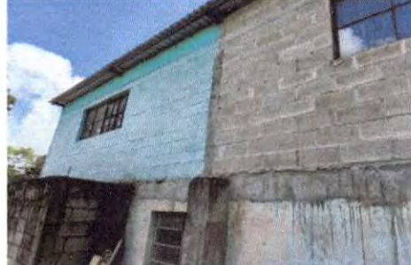
Reparación de cernido y repello en pared exterior No.2 por grietas provocadas por humedad
