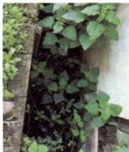
Reparación del muro perimetral No.3 debido a la humedad, pequeños deslaves de tierra y por el ripio que los vecinos mantienen en el área
