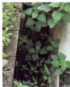
Reparación y refuerzo de bajada de agua pluvial No.2 Ya que se encuentra ostruida y el agua desemboca en las paredes de la cocina
