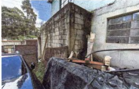
Reparación de cernido y repello en pared exterior No.3 por grietas provocadas por humedad
