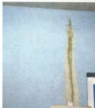
Foto 10: Reparar Bajada Pluvial, demoler, Reparar y resanar
