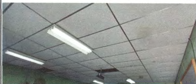
Foto 3: cambio de piezas de cielo falso y mejorar iluminación
