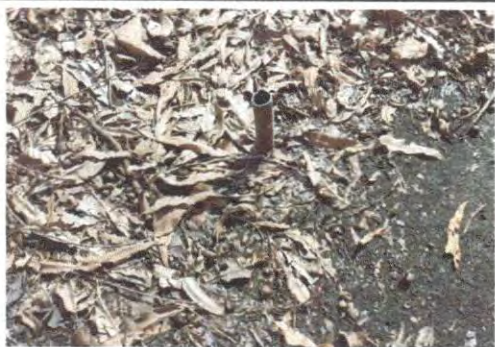
Foto 9: Sella tuberías electricas en terraza
