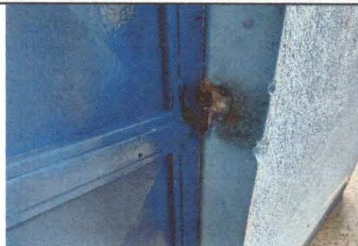
Foto 2: Ajuste de 1 pasador de 1 puerta baño de estudiantes
