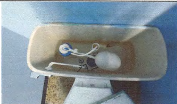
Foto1: Cambio de accesorios de 6 inodoros
