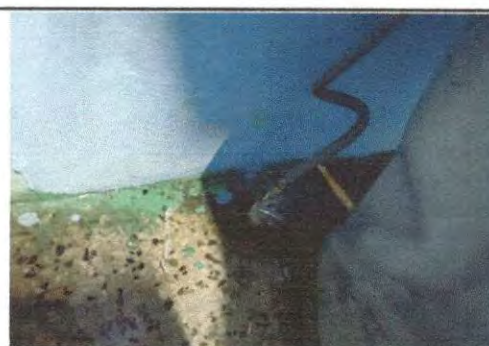
Foto 6: Cambio de mangueras y contrallaves de 6 inodoros
