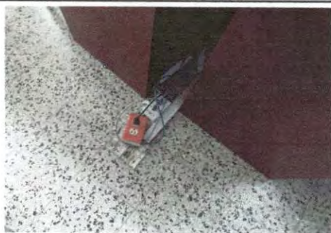
Foto 5: Recortar regleta y mover instalaciones de fuerza y red
